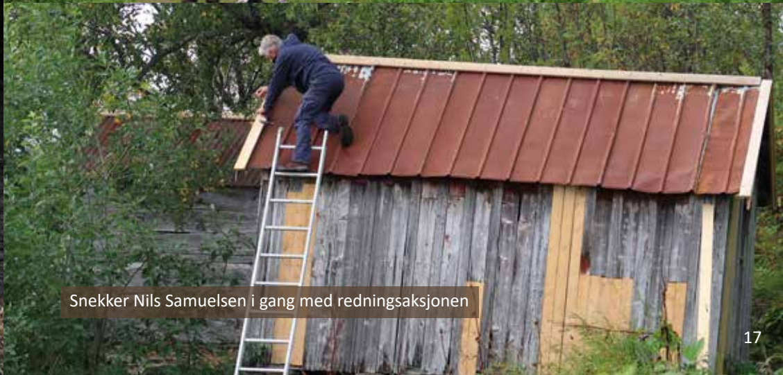
Det gamle torvtaket på Fjørtofthytta ble fjernet på dugnad og presenning ble lagt i påvente av nytt tak.
